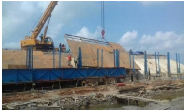
Gambar 2. Proses Perakitan Kontruksi Loading Ramp
