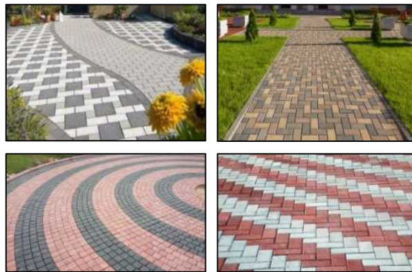
Gambar 1. Pola pemasangan paving block
