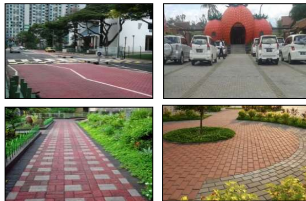
Gambar 2. Penggunaan Paving Block
